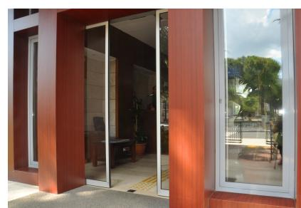
Muğla Orman Bölge Müdürlüğü giriş kapısında 1 adet record D-STA 20 çift kanatlı doğrusal standart yana kayar kapı, elektronik kilit sistemi (VRR), record RIC 290 AC perde fotoselli radar ile maksimum geçiş güvenliği, record RAD 290 AC radar ile istenilen özelliklerde tetikleme sağlanmıştır.
